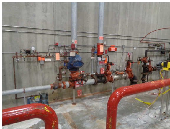
54. Fire sprinkler risers
